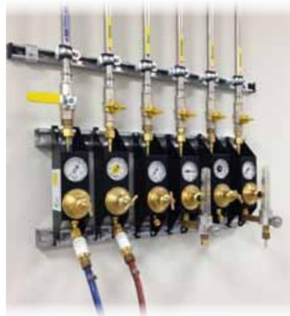
Das vorgeschaltete Absperrventil dient dazu, einzelne Entnahmestellen auch kurzfristig abzuschalten oder einzelne Arbeitsplätze außer Betrieb zu setzen, ohne die gesamte Gasversorgung zu sperren oder das Druckverhältnis neu justieren zu müssen.
